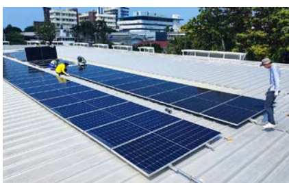
ติดตั้งระบบผลิตไฟฟ้าพลังงานแสงอาทิตย์ (Solar Cell)
