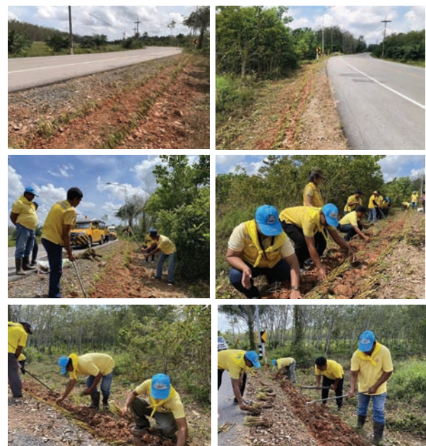
ถนนสาย พท.1042 แยกทางหลวงหมายเลข 4 - บ้านถ้ำน้ำเย็น อำเภอเขาชัยสน จังหวัดพัทลุง
