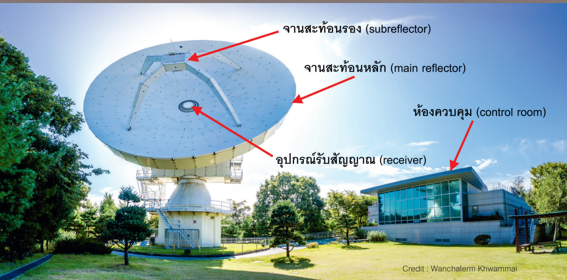
ภาพที่ 20 แสดงส่วนประกอบสำคัญของกล้องโทรทรรศน์วิทยุเควีเอ็น ย็อนเซ (KVN Yonsei) ที่ประเทศเกาหลีใต้
